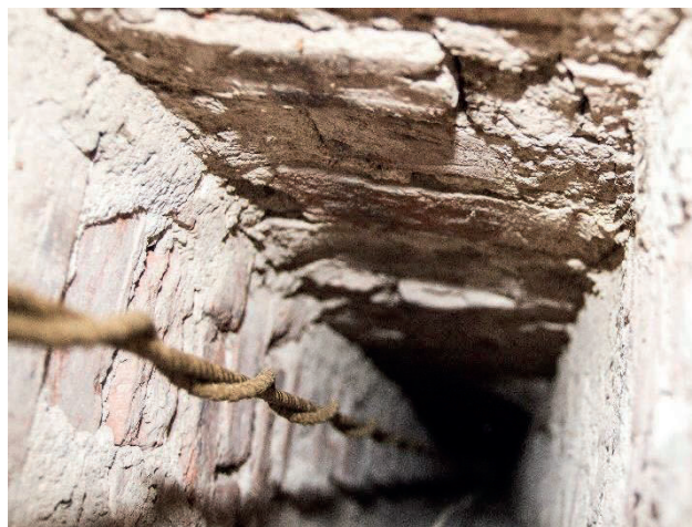
Lodtrumma i Sturehovs slott. Linan har tvinnat sig då lodet nådde botten.
