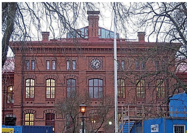
Fasaduret mot parken i kv. Mimer i den byggnad som tidigare varit, i tur och ordning, barnhus, barnsjukhus, Norrtulls sjukhus och nu skola. Foto E. Read 2014.
